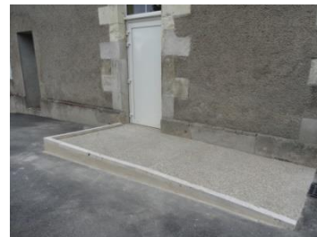
Création d'une rampe d'accès à la cantine
