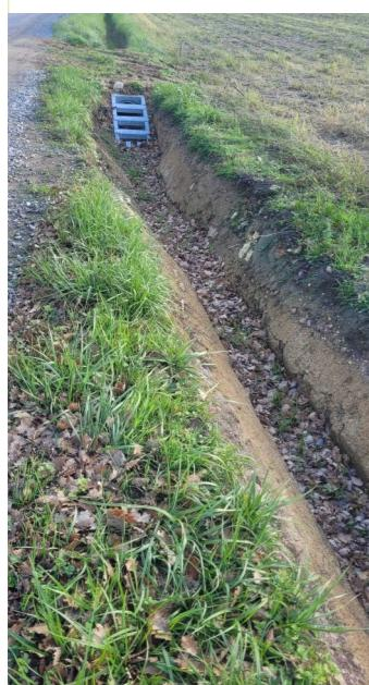
Outre les réfections d'enrobés programmées, « **Le Puits Béral** » a fait l'objet de travaux de route (**reprofilage du fossé, des accotements et busage**) pour un montant total de **22 914, 61€**. Non prévus au budget 2025, ceux-ci se sont avérés nécessaires pour un meilleur écoulement des eaux pluviales.
