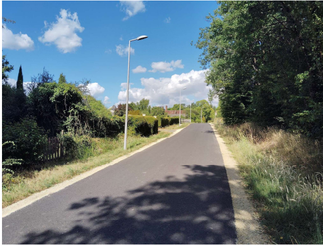
Vue vers le bourg - Rue la Croix de Paradis
